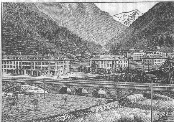
EISENBAHNBRÜCKE ÜBER DIE LINTH UND SERNFT IN SCHWANDEN
