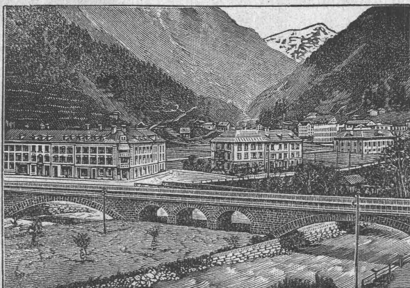
EISENBAHNBRÜCKE ÜBER DIE LINTH-UND-SERNFT- IN SCHWANDEN
