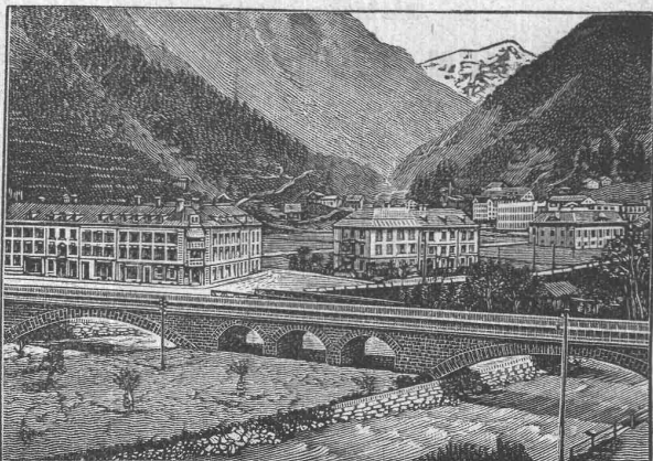
EISENBAHNBRÜCKE ÜBER DIE LINTH-UND-SERNFT IN SCHWANDEN
