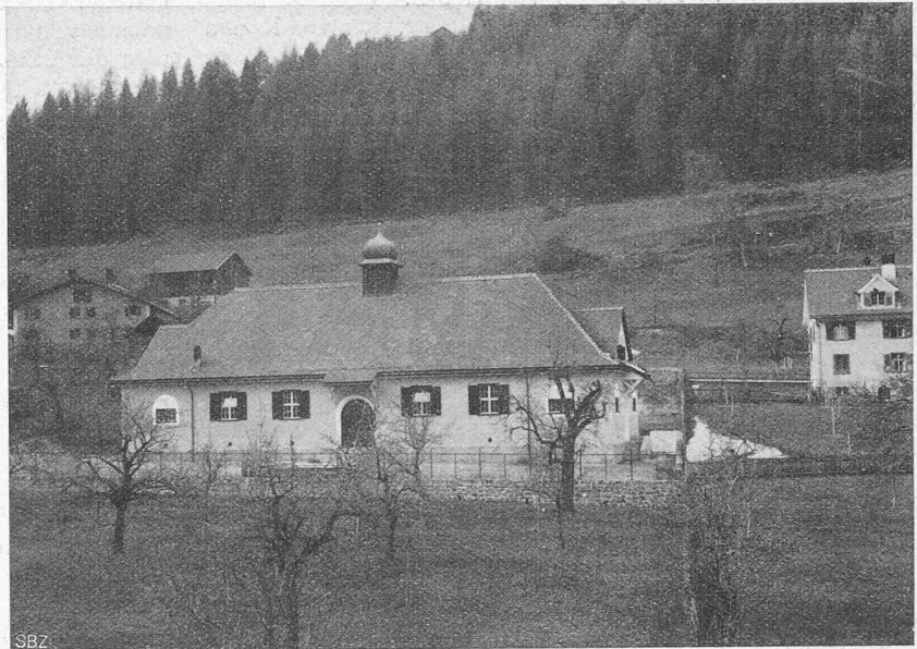
Abb. 2. Ostansicht der neuen Turnhalle der Gemeinde Thusis.
