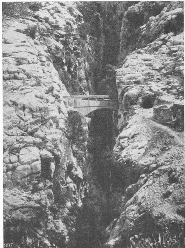
Fig. 13. Vue d'amont de l'aqueduc sur le Guadiaro.
