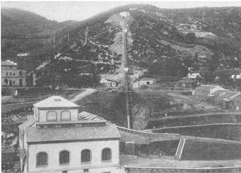
Fig. 20. Vue générale de la chambre d'eau, de la conduite forcée et de l'usine de Buitreras.
