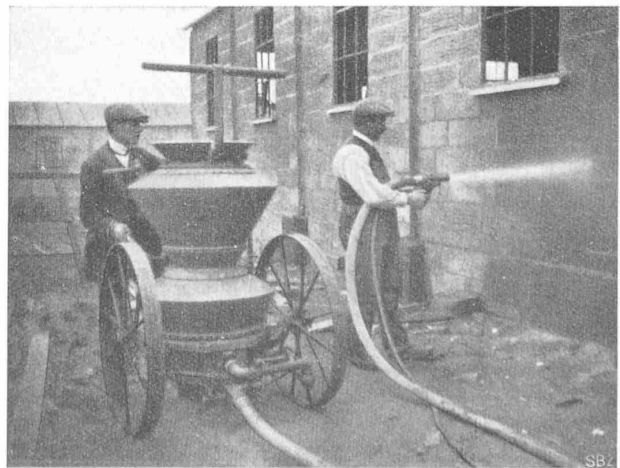
Abb. 3. Verputzen einer Gebäude-Fassade mittels der Zementkanone; Handregulierung des durch den dünnen Schlauch zugeführten Anmachwassers.
