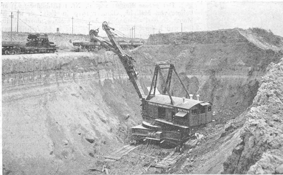
Abb. 26. Elektrischer Löffelbagger Typ 225 B der „Hydro“, in Erde arbeitend. Fassungsvermögen: in Erde 6 m 3 bei 50 sek Spieldauer, in Fels 3,8 m 3 bei 80 sek Spieldauer.
