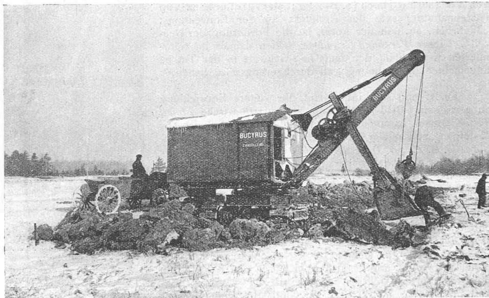
Abb. 31. Kleinster elektrischer Löffelbagger, auf Radgürtel, der Hydro Electric Power Commission of Ontario. Fassungsvermögen des Löffels in Erde 0,7 m 3 .
