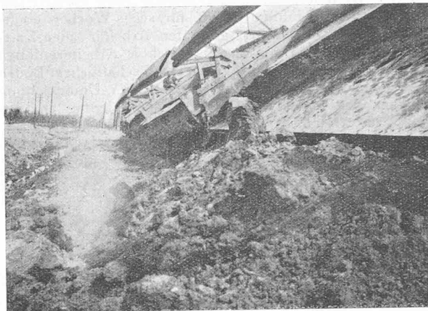
Abb. 54. Gekippter Materialzug in der Deponie.
