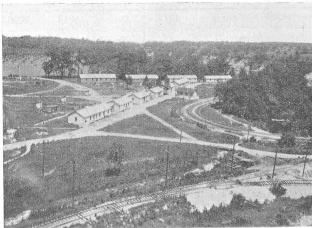
Abb. 59. Arbeiterkolonie der „Hydro“ beim Vorbecken.
