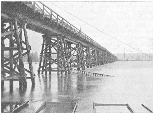
Abb. 16. 700 m lange Behelfsbrücke über die Maas bei Visé.
