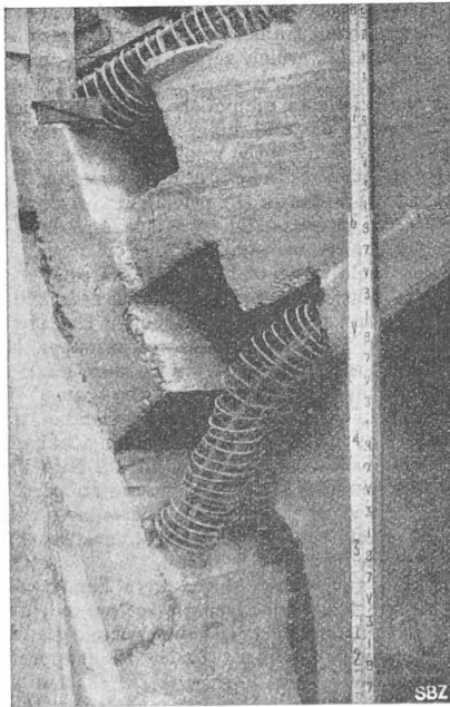
Abb. 3. Provisorisches Gelenk am Kämpfer.
