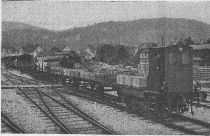
Akkumulatoren-Lokomotive für den Verschiebedienst in den BBC-Werkstätten und auf dem Bahnhof Baden.
