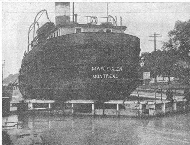
Abb. 6. Schleuse bei Thorold im kanadischen „Welland-Kanal“. Länge 85 m, Breite 14 m, Drempeltiefe 4,4 m. Hölzerne Stemmtoore.
