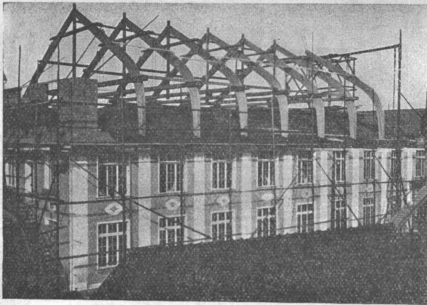
Stockwerksaufbau einer Fabrik nach Hetzer'scher Bauart.
