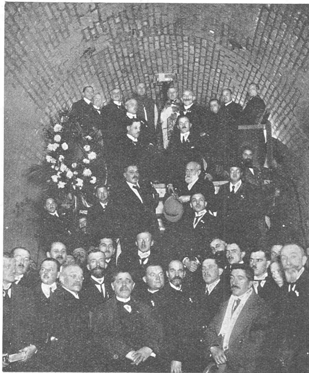
Feierliche Einsetzung des Schlusssteines im Simplon-Tunnel II am Barbaratag (4. Dez.) 1921 bei Km. 11,6 ab Nordportal.
