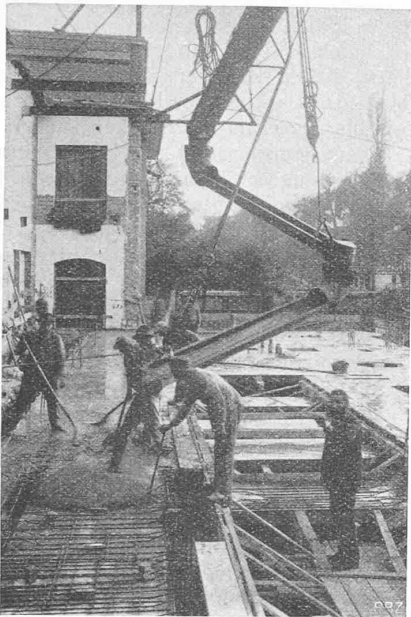
Abb. 4. Ausguss-Ende des Betongerinnes.
