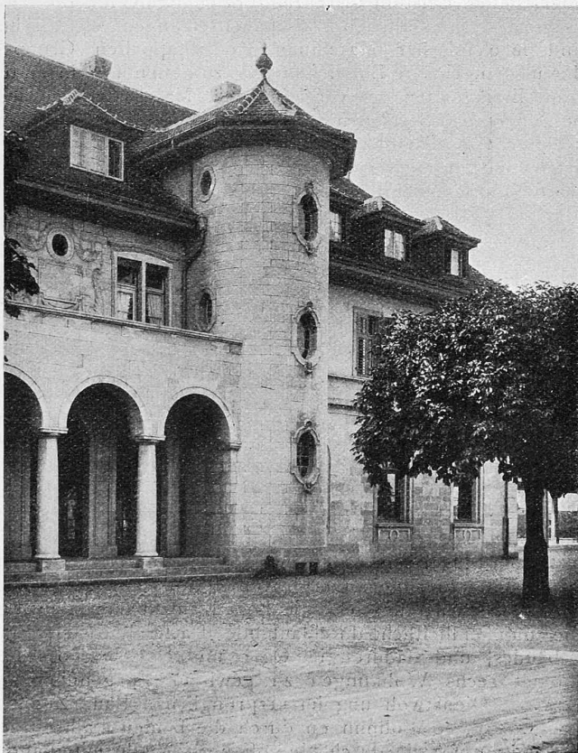
Abb. 6. Vorhalle und Treppenturm des umgebauten Bahnhofs Brugg.
