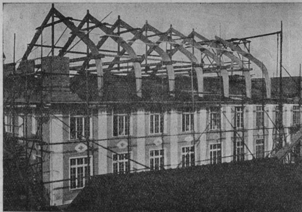
Stockwerksaufbau einer Fabrik nach Hetzer'scher Bauart.
