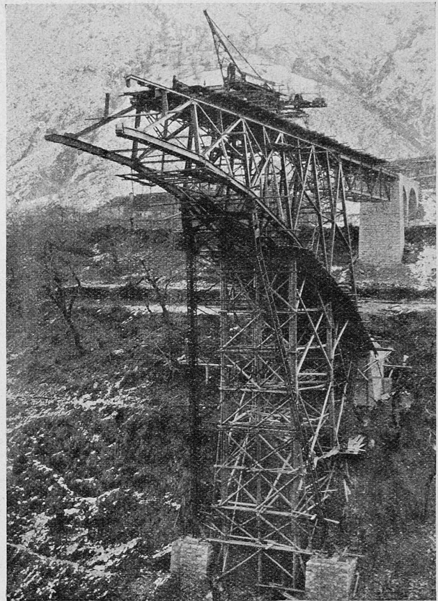
Abb. 10. Montage am rechten Hang, Bauzustand 27. XII. 1915.
