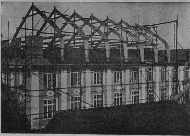
Stockwerksaufbau einer Fabrik nach Hetzer'scher Bauart.
