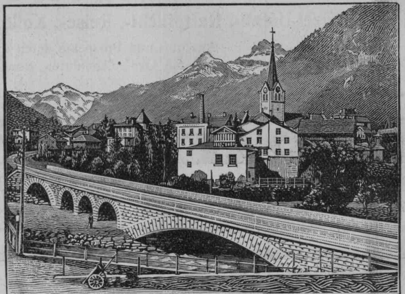
Eisenbahnbrücke ü. d. beiden Lintharme i. Schwanden
