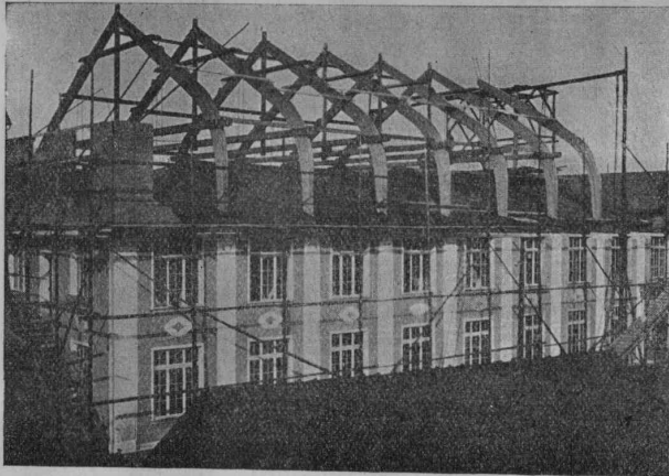
Stockwerksaufbau einer Fabrik nach Hetzer'scher Bauart.
