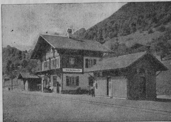
Station der Brienerseebah Eternit-Doppeldach, kupferbraun.
