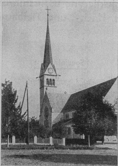
Kirchturm in Wettingen. Bedachung: Eternit-Doppeldach, kupferbraun.
