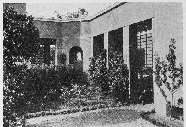
Abb. 2. Verbindungs-Pergola der beiden Häuserreihen.
