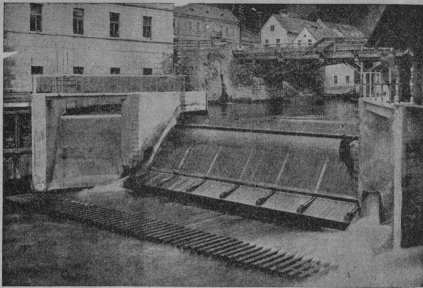
Dachwehr in der Mürz der Kabelwerke Felten & Guillaume, Bruck a. d. Mur.
