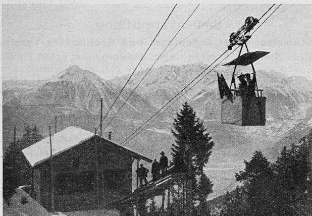
Abb. 16. Untere Station der Luftseilbahn bei Les Garettes.
