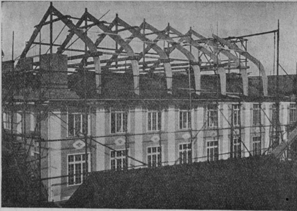
Stockwerksaufbau einer Fabrik nach Hetzer'scher Bauart.
