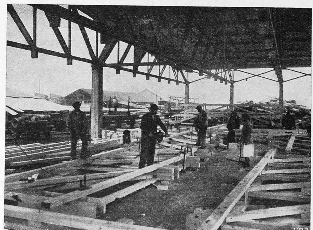
Abb. 12. Elektrisches Bohren der Konstruktionen am Abbundplatz.
