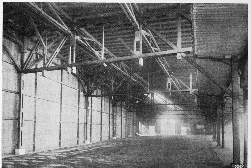
Abb. 11. Perronhalle im Bahnhof Genf-Cornavin, Innenansicht gegen den Ausgang.
