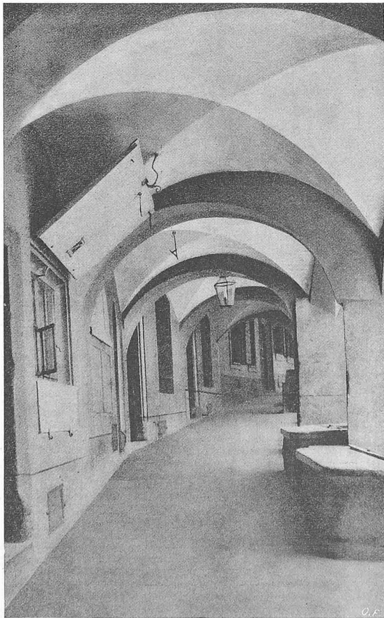
Lauben an der untern Junkerengasse (vergl. Seite 143) mit den mittelalterlichen Fensterverschlüssen durch Klapppläden.
