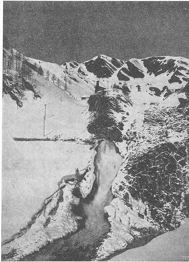
Abb. 7. Ausmündung des Grundablass-Stollens in den Fossbach (6. III. 1917).
