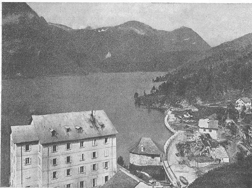
Abb. 12. Staumauer und Schieberhaus der Wasserfassung am Ritom-See.
