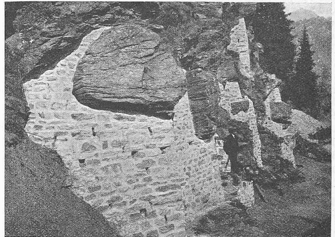
Abb. 33. Sicherungsarbeiten an der Strasse Wasserschloss-Ritomsee.
