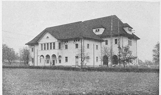
Abb. 2. Das Unterwerk Steinen im Kanton Schwyz.
