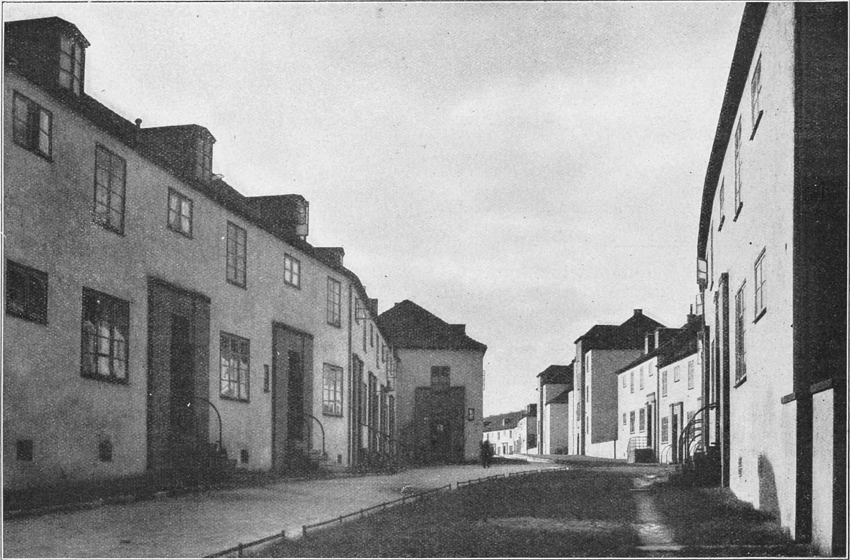
Abb. 3. Aus der Siedlung Essen-Stadtwald von Arch. Jos. Rings. — Die Strasse „Hagelkreuz“, gegen Westen gesehen.
