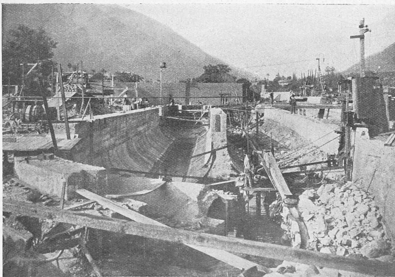
Abb. 8. Automatische Entsandungs-Anlage des Kraftwerk Yanacoto (Peru) im Bau.
