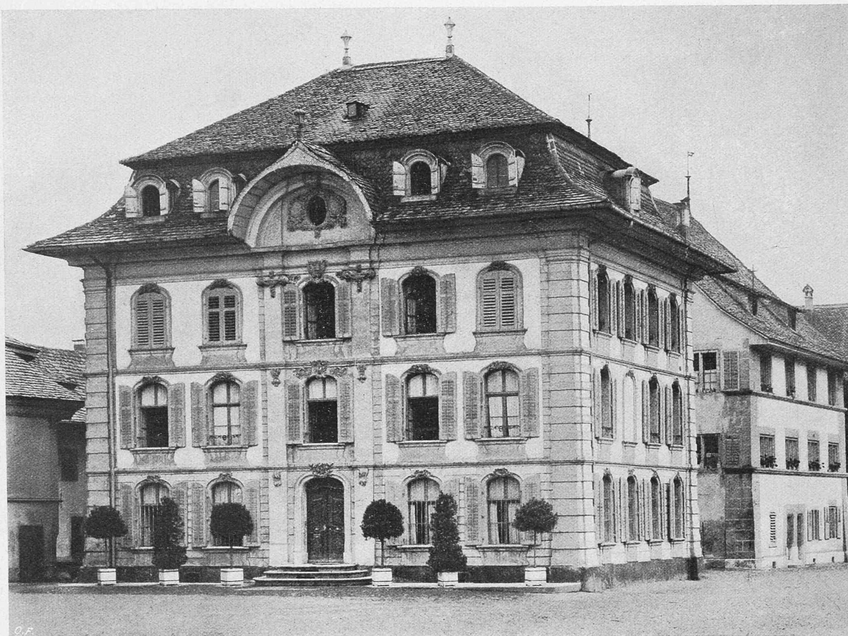
Das „Neuhaus“ in Zofingen, erbaut um 1770 durch Architekt Joh. Jak. Ringier. (Aus: „Bürgerhaus des Kanton Aargau“).
