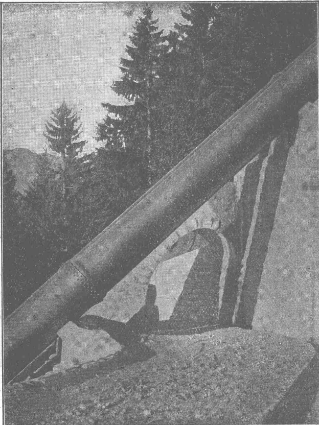
Turbinenleitung des Ritomwerkes der S B B mit Nietmuffenverbindung, Gefälle 830 m, geliefert von Thyssen & Co. A.-G., Abteilung Stahl- und Walzwerke, Mülheim a. d. Ruhr, durch die Firma Escher Wyss & Co., Zürich.
