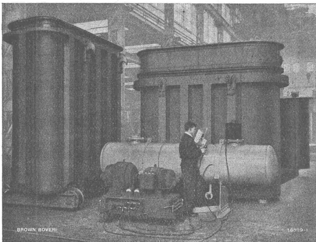
Mit Brown Boveri Lichtbogen-Schweißgruppen elektrisch geschweißte Groß-Transformatorenkessel.
