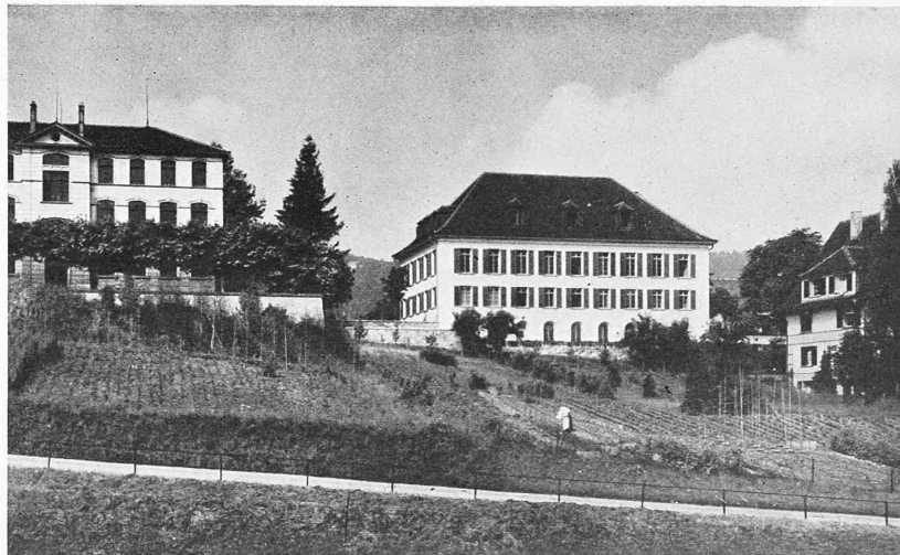
ANSICHT VON DER SEESEITE, LINKS SCHULHAUS, RECHTS SAALBAU
