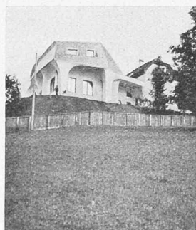
Abb. 18. „Anbau“ aus NW.
