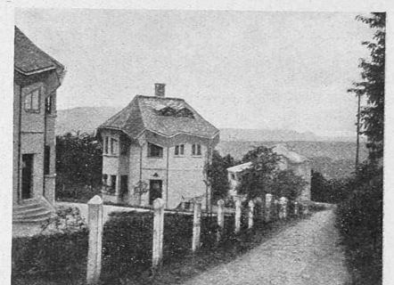
Abb. 14. Doppel-Wohnhaus u. Atelier (im Hintergrund).
