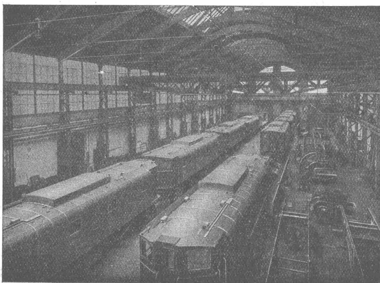
Lokomotiv-Montagehalle mit elektrischen Lokomotiven für Südafrika
