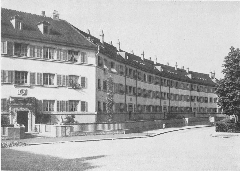
WOHNKOLONIE IM LETTEN DER BAUGENOSSENSCHAFT DES EIDGEN. PERSONALS IN ZÜRICH HÄUSER-REIHE AN DER IMFELDSTRASSE, AUS NORDOST
