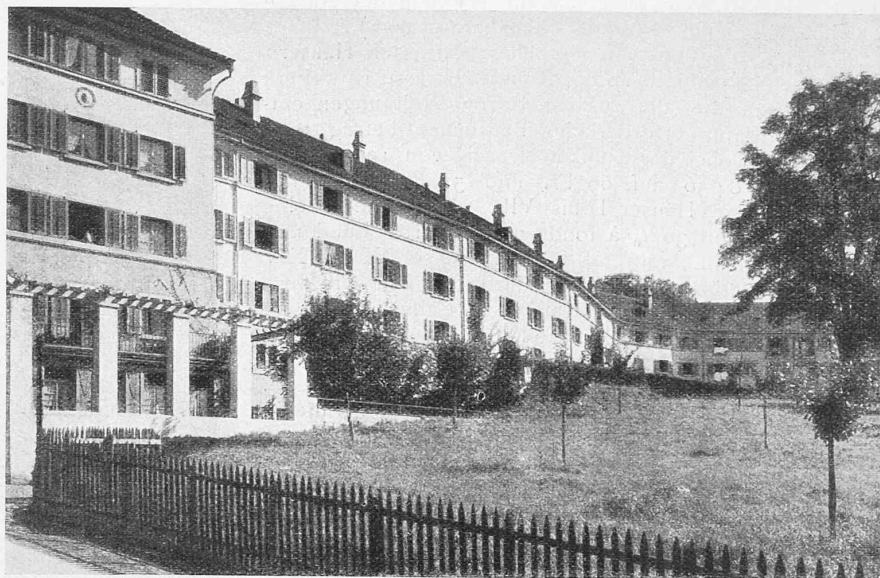
Abb. 12. Rückseite der Häuser an der Imfeldstrasse, aus Südwest.
