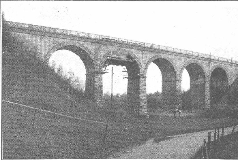
Viadukt bei Goldach S. B. B., Rekonstruktion Bau-Unternehmung Siegrist-Merz & Co., St. Gallen.
