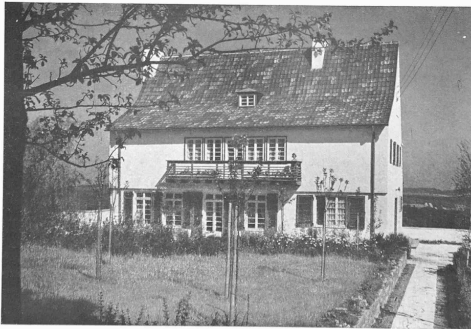
HAUS BONATZ IN STUTTART, SÜDSEITE
