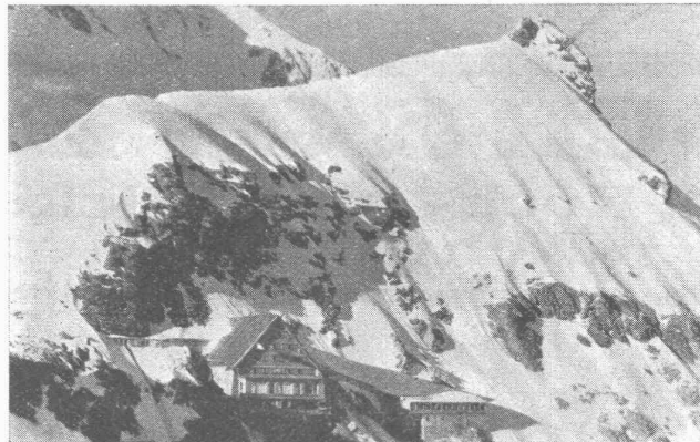
Gletscherwasser während des Druckes mit «SIKA» gedichtet und mit «Anfifrost» betoniert
