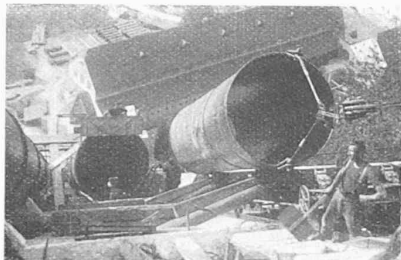
Abb. 55. Abrollen eines Rohres vom Seilbahnwagen. (Aufnahme 6. VII 23.)
