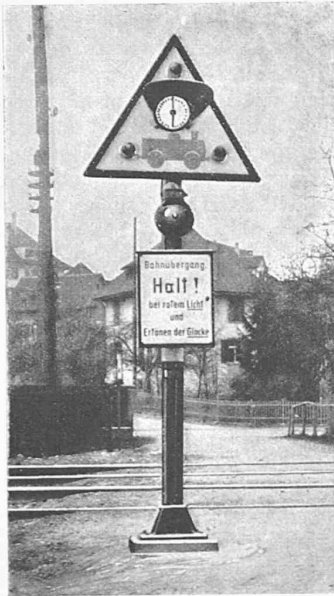
Abb. 7. Blinklicht-Signal mit drei Lampen der Signum A.-G., Wallisellen.
