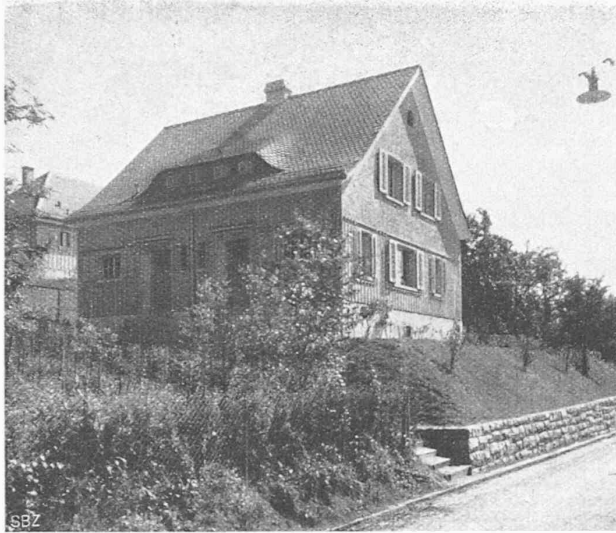
Abb. 3. Haus IV von Norden.
