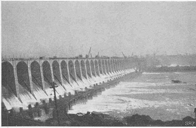
Abb. 5. Das Wilson-Stauwehr, vom rechten Ufer aus gesehen, mit teilweise geöffneten Ueberfall-Schützen.
